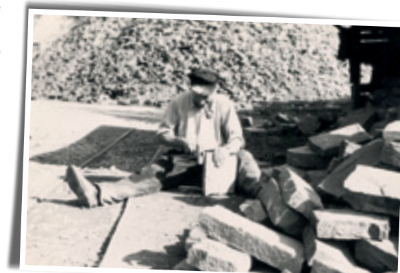
Steinhauer beim Bearbeiten der Grauwacke
