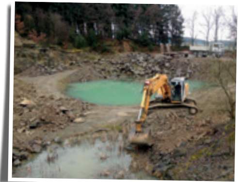
Baggerarbeiten im Steinbruch
