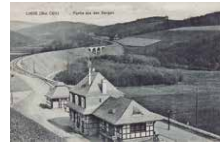
Die soeben eröffnete Sülztalbahn mit dem Bahnhof Linde und dem Viadukt über das Sülztal, durch das noch keine Straße führte, auf einer Postkarte aus dem Jahr 1912.
