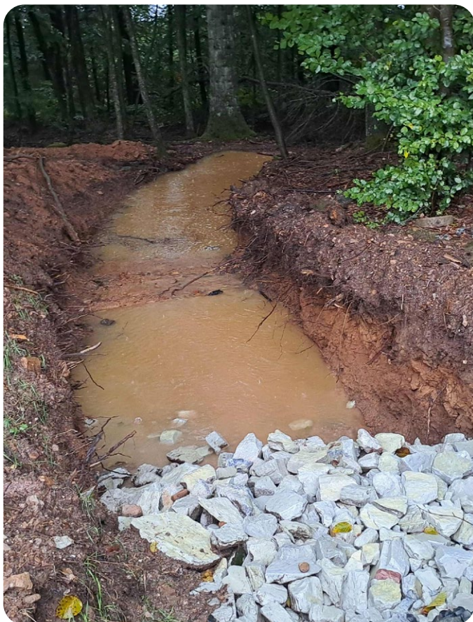
Durch das Anlegen von Rigolen wird der Wasserrückhalt in der Fläche gefördert.
